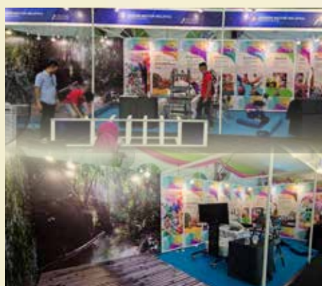
Kerja-kerja pemasangan dan persiapan pameran
